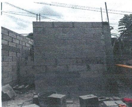
Foto 3 En la presente imagen nos muestra tambien el avance de las paredes que será la entrada principal hacia los sanitarios
